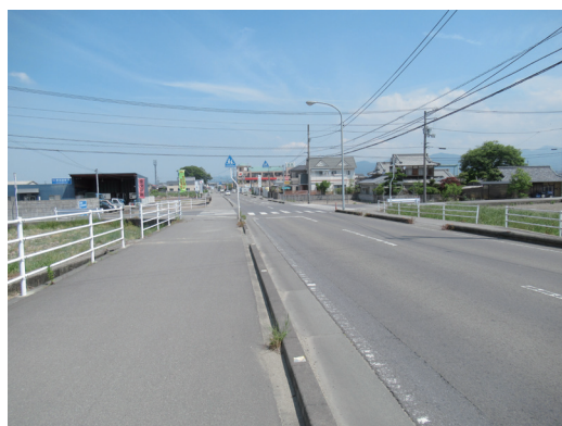
① 東方町久谷浄水場東県道 交差点
