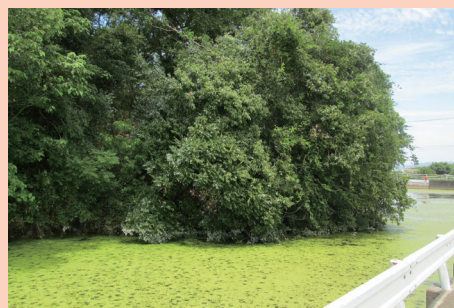
東側土塁被災状況(H30年7月12日)
