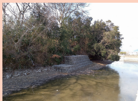
東側土塁かご枠工事完成(R3年2月8日)
