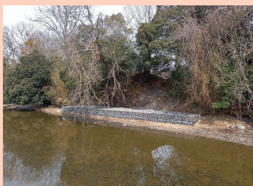
西側土塁かご枠工事下段完成(令和4年3月10日)
